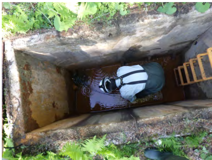
地中の水を集めるための水抜孔の洗浄作業
