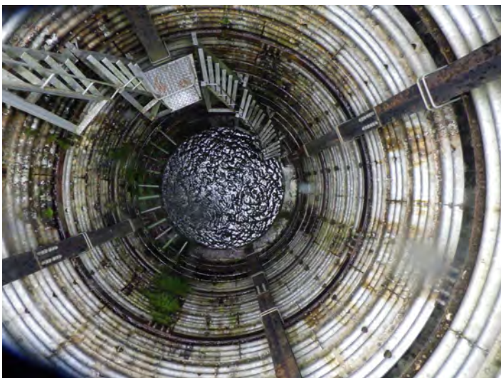
地下水を集め排水するための集水井の変状確認
