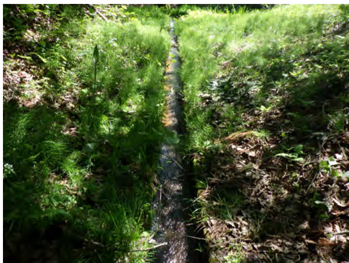
地表水を流すための水路の通水確認
