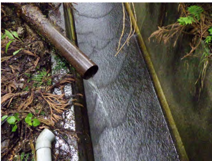
農業用水として利用するための導水管の通水確認
