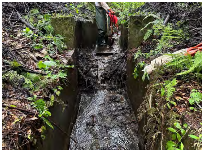
土砂撤去前の集水枥（しゅうすいす）
