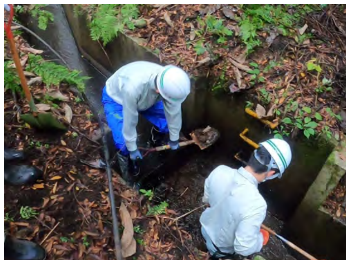
土砂撤去作業の様子
