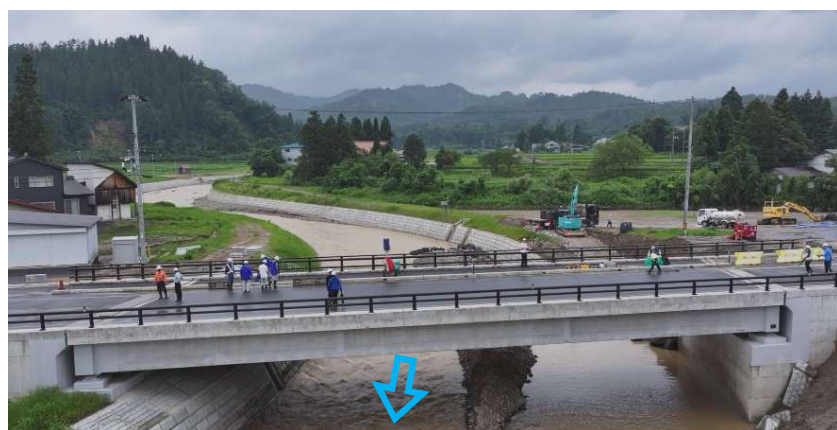
橋の安全性確認状況
