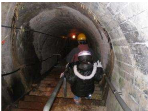
▲ホラー映画の撮影現場となった監査廊
