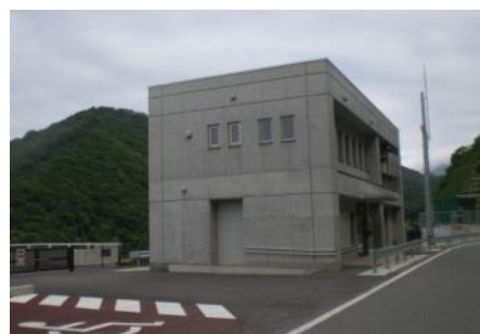
▲ダム管理所外観
