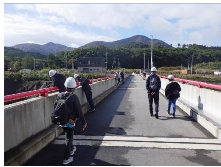
▲ダム天端見学の様子
