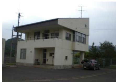
▲ダム管理所外観
