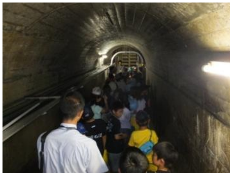
▲ダム内部通路での説明
