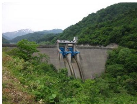
▲右岸駐車帯からダム下流面
