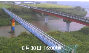
相沢橋水位観測所付近状況 (下流を望む)
