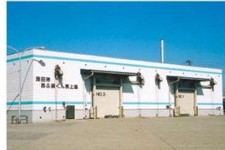
西ふ頭くん蒸施設
