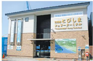
定期船とびしまフェリーターミナル
