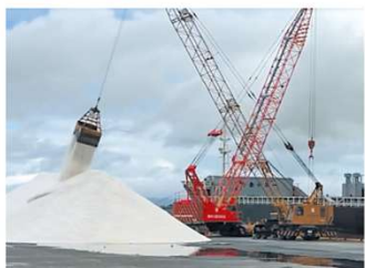
大浜ふ頭第1岸壁
