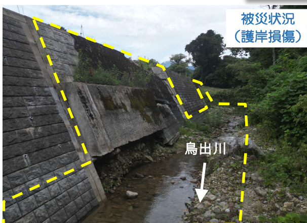
大雨で増えた河川の水で河底が削れ、護岸が崩れました
