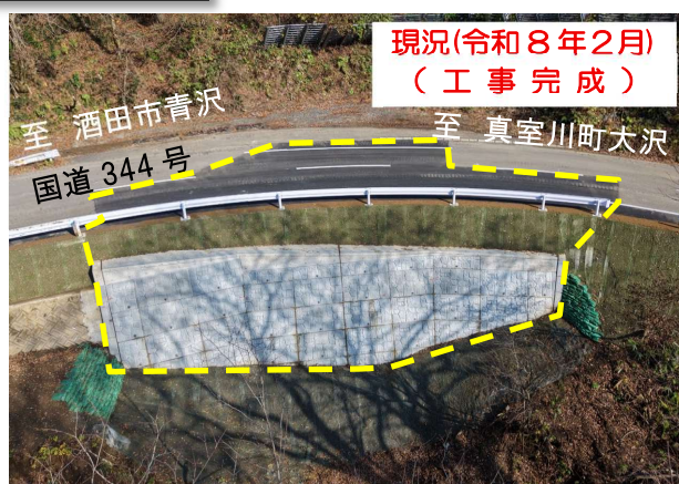
大型コンクリートブロックで道路を復旧しました
