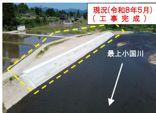
崩れた護岸をコンクリートブロックで復旧しました
