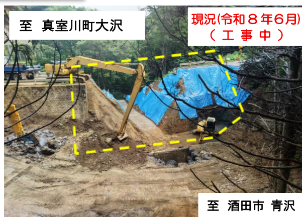
地下排水管復旧のため道路を開削しています
