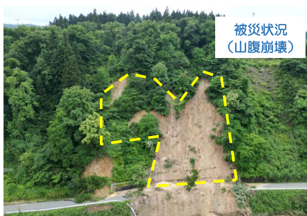
大雨で山腹崩壊が発生し土砂が流出しました
