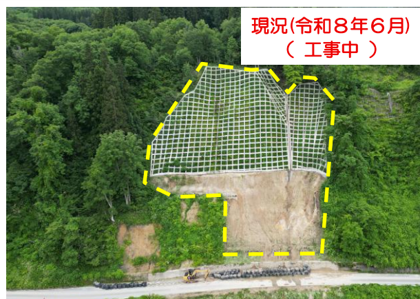
崩れた山腹を法枠工等で復旧中
