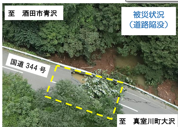
大雨で道路が崩れました
