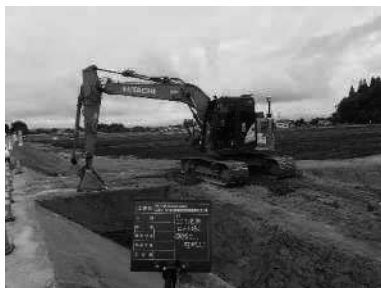
丁張なしでの法面整形作業
