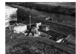
荒田排水機場
