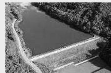
【新庄市】ため池の改修を行い、洪水被害を抑制
