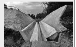
【村山市】ため池の堤体を開削し、貯留機能を廃止
