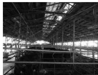
牛舎への送風機の設置
