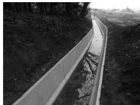
整備補修したコンクリート水路
