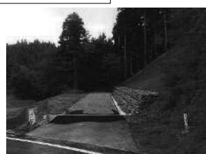
復旧状況(かご擁壁工等)
