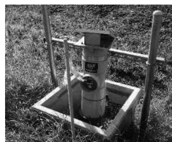
自動給水栓の設置（酒田市）
