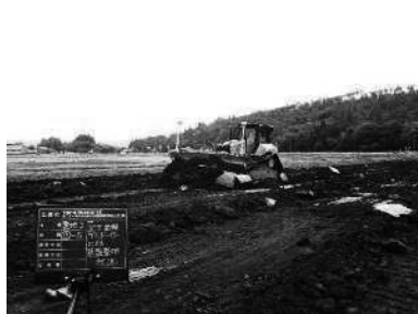
ICT 建設機械による基盤整地
