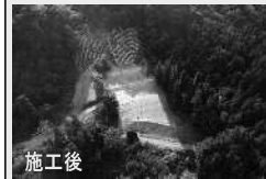
山腹工の施工（飯豊町）
