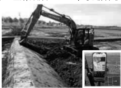
MCバックホウによる法面整形
