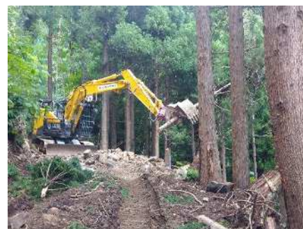
森林作業道の開設状況
