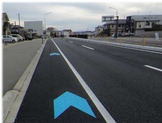
既設道路への矢羽根設置(路面標示)
