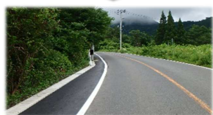
側溝整備と路肩拡幅による 自転車通行空間の整備
