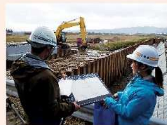
業者との現場確認
