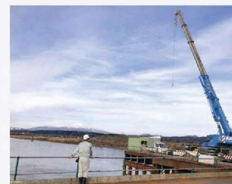
橋梁工事の状況確認
