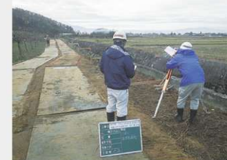
工事段階確認中
