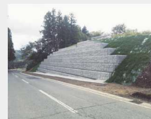
道路改良工事(箱型擁壁)
