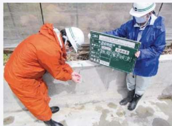
水路工事の完成検査
