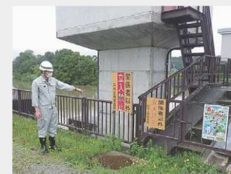
水利施設点検
