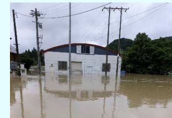
R6.7月豪雨におけるポンプ場冠水状況
