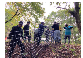
侵入防止柵の設置
