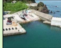
船揚げ場 (斜路部コンクリート腹付け)
