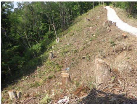
都市公園境界部の緩衝帯整備
