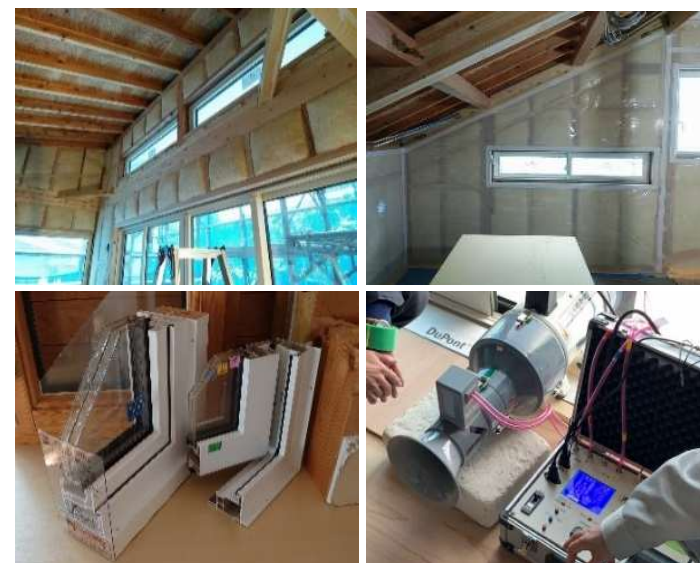
仕様 断熱材の厚さが国の基準の約2倍 隙間面積がはがき1枚以下の気密性能（有資格者による気密試験）
