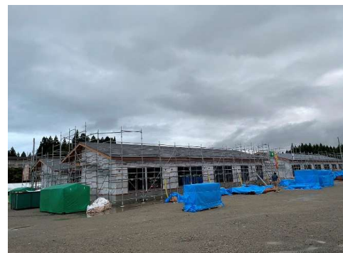
R6.9.15 外装、内装工事中
