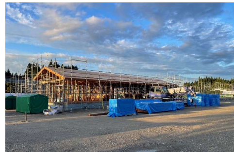
R6.9.8 建方完了
