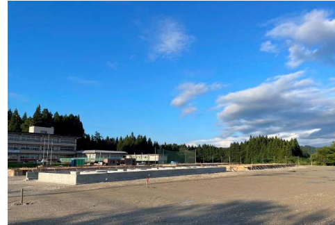
R6.9.3 基礎工事完了
