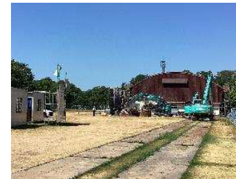
現場における状況確認
