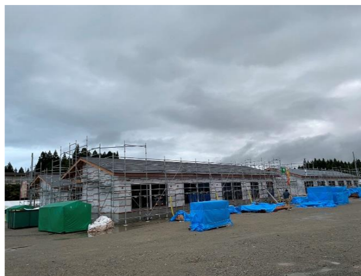
R6.9.15 外装、内装工事中
