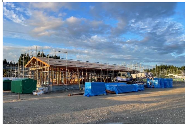
R6.9.8 建方完了
