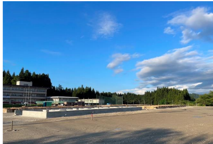
R6.9.3 基礎工事完了
