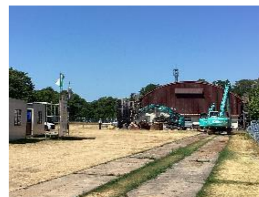
現場における状況確認
