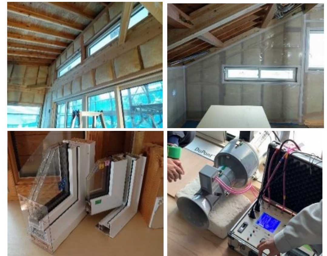
仕様 断熱材の厚さが国の基準の約2倍 隙間面積がはがき1枚以下の気密性能(有資格者による気密試験)
